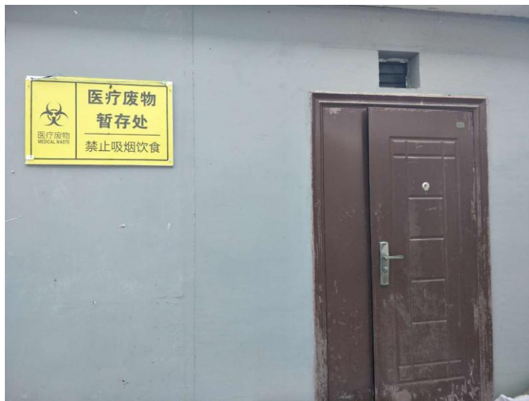
图 4-2 医疗废物暂存间现场照片
